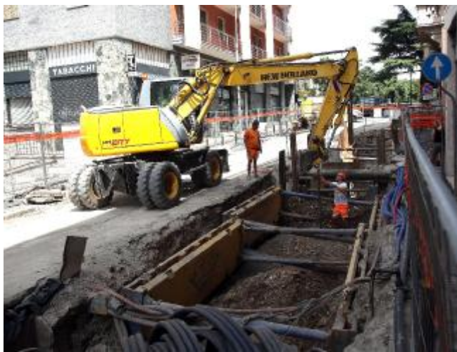
Il cantiere in via Corsica interessa oramai da tre mesi il quartiere
